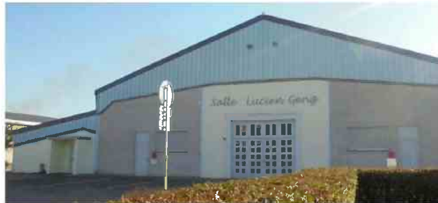
La salle Geng sera conservée mais nécessitera d'importants travaux. PHOTO L'ALSACE/J.-P.F.
