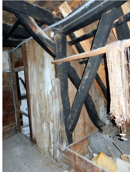
En comble, vue intérieure de la soupenne est (cloison de 1535-1540) et détails des fermes-maîtresses de la charpente de 1475-1477.
