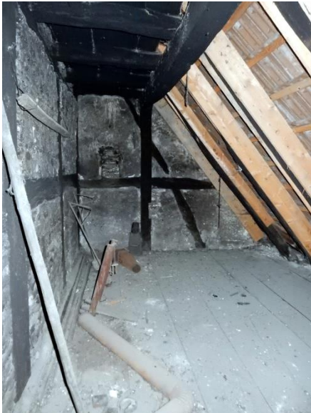
En comble, vue intérieure de la soupenne est (cloison de 1535-1540) et détails des fermes-maîtresses de la charpente de 1475-1477.
