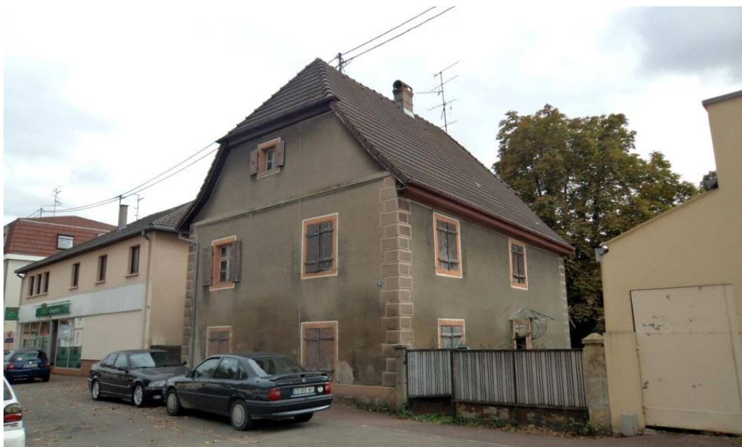
Habsheim, 2015 : une maison d'allure carrée et d'aspect anodin. Remarquer le retrait de la partie supérieure du pignon sur rue par rapport aux maçonneries des parties inférieures.
