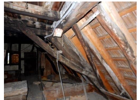
En comble, vue intérieure de la soupenne est (cloison de 1535-1540) et détails des fermes-maîtresses de la charpente de 1475-1477.
